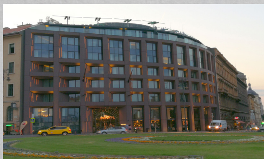
Præfabrikeret element bygnings facade
