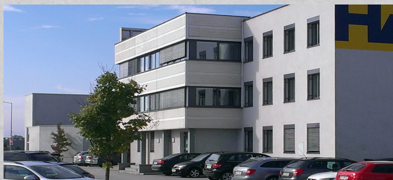
Præfabrikeret element bygning facade
