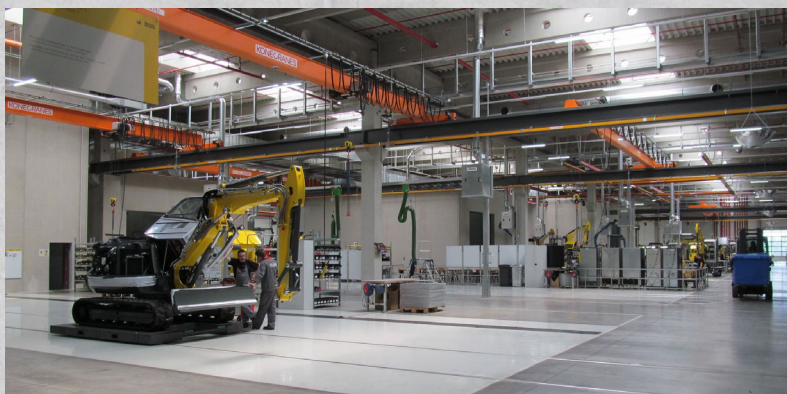
Industri hal 50000 m2 kun forstærket med Fibrofor High Grade, fugefri
